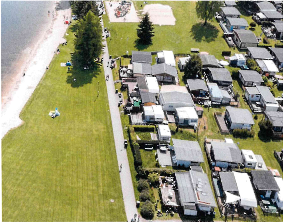
Abbildung 7: bauliche Anlagen / Bungalows Campingpark Greifensteine GmbH
