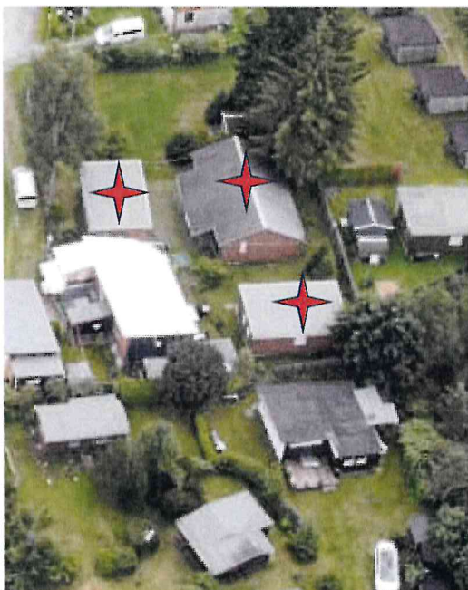
Abbildung 10: bauliche Anlagen / Bungalows Indira Gandhi
